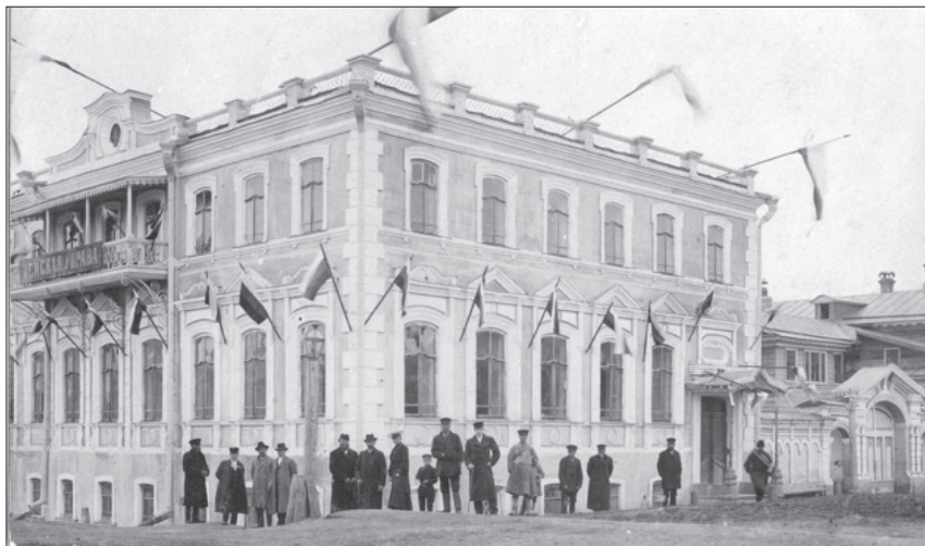
Здание Яранской уездной земской управы.
