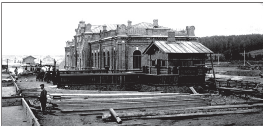
Строительство вокзала Вятка II Пермь-Котласской железной дороги. Фото конца XIX века. Источник: https://rodnaia-vyatka.ru/comment/75973
