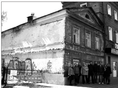
Дом по ул. Спасской, 38 до ремонта. Апрель 2018 г. Фото М. Рушиновой
