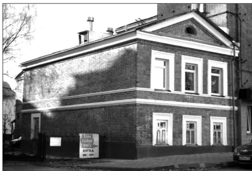
Дом по ул. Спасской, 38 после ремонта. Октябрь 2018 г. Фото М. Рушиновой
