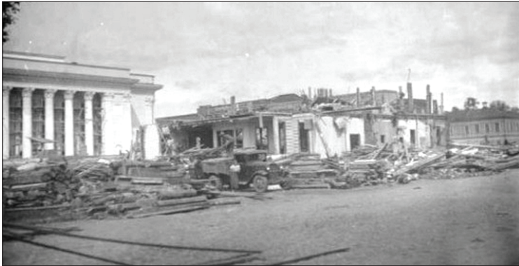
Строительство драмтеатра в г. Кирове. 1939 г. ГАСПИ КО. Ф. Р-6976. Оп. 1. Д. 254
