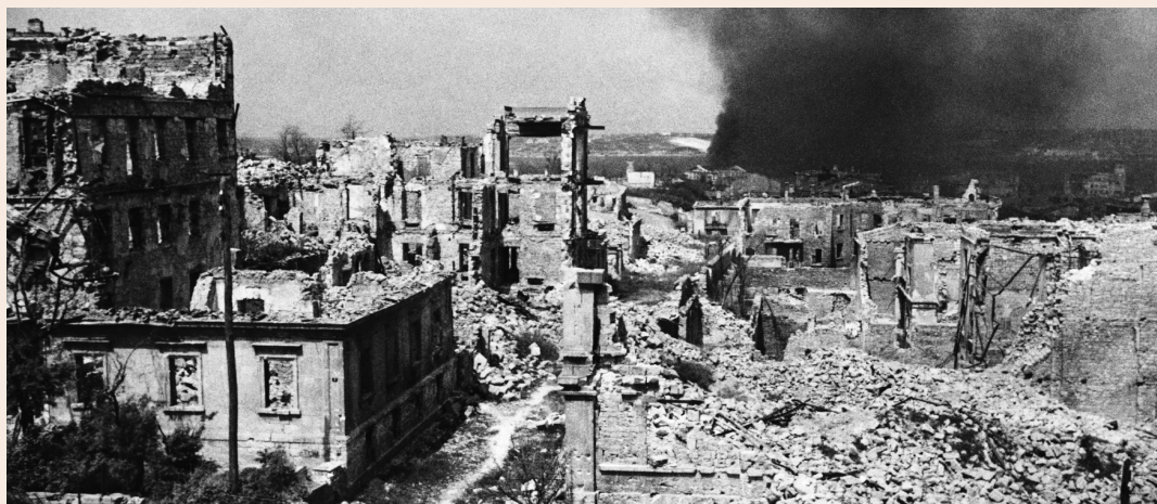
1 Руины здания военно-исторического музея Черноморского флота на улице Ленина, разрушенного немецкими войсками во время Великой Отечественной войны, г. Севастополь, 1944
