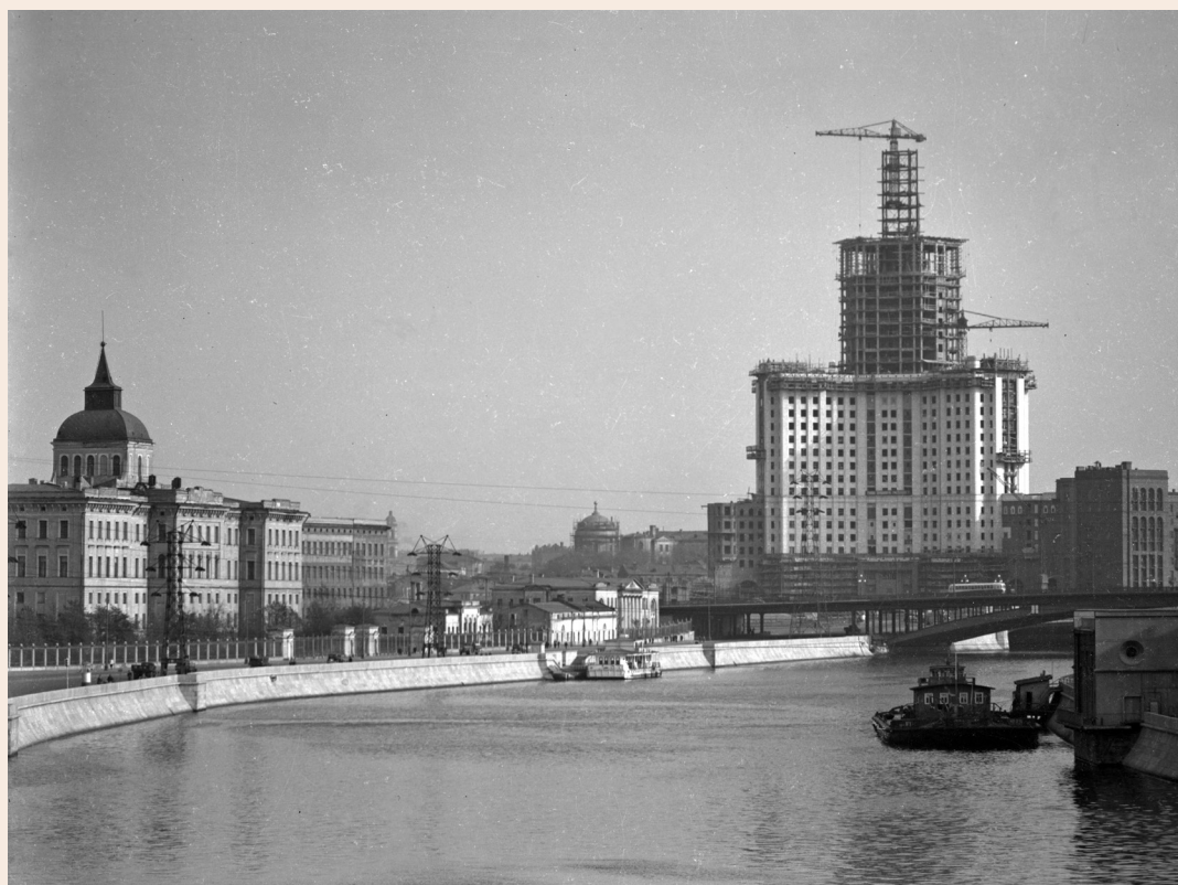
I Строительство высотного здания на Котельнической набережной, 1948
