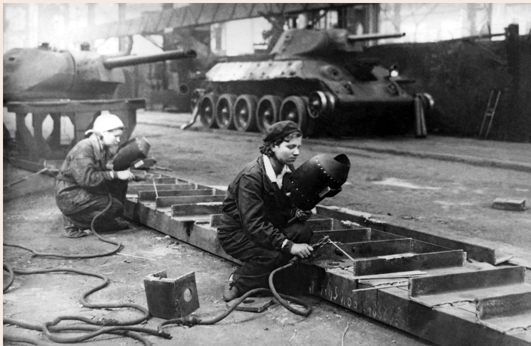
Женщины-сварщицы за работой, 1942
