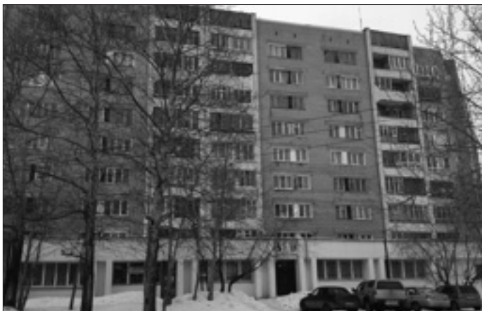
Здание, в котором разместился центр «Вифлеем в Вятке». г. Киров. 2014 г.
